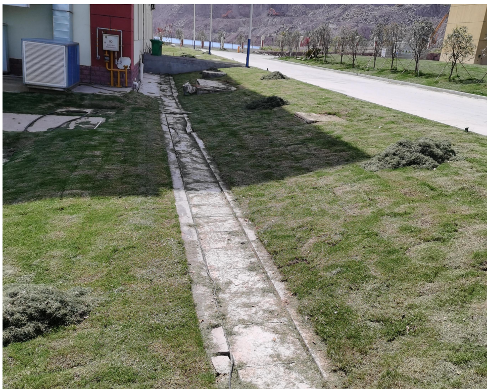
厂区绿化工程 2
