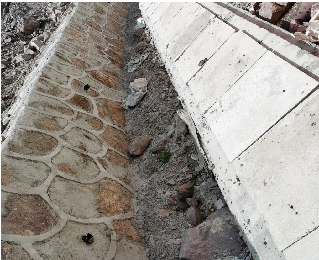
厂区排水工程
